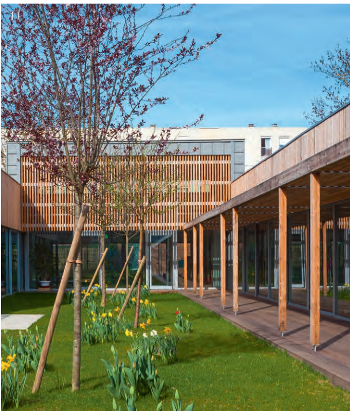
1 | Ecole Maternelle Gérard Reillon, Bois d'Arcy (78) Architectes : Pascaline Guillier et Véronique Jandelle (75) - Entreprise : Plastalu (21) Photos : Hervé Abbadie
